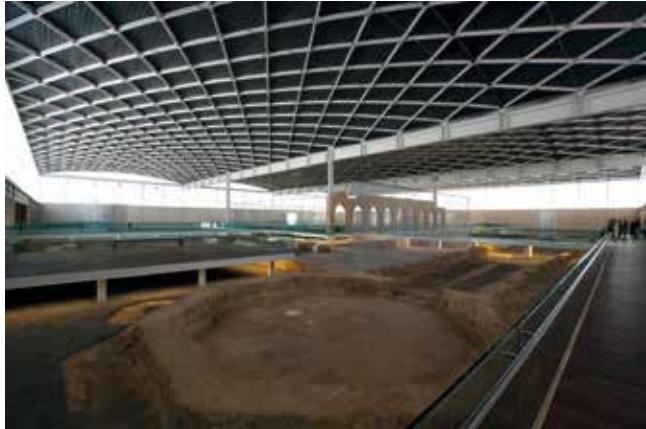
Fig. 29. Vista interior del edificio contemporáneo.
