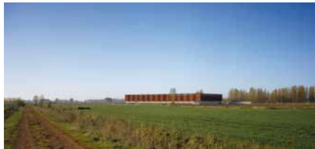
Fig. 32. Vista exterior e integración en el paisaje. Imagen de Roland Halbe.
